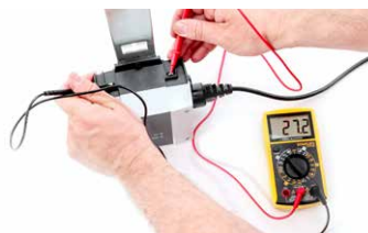
Spanning op de lader controleren
