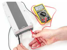
Spanning op de batterij controleren
