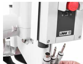
Überprüfung der Kabelverbindung
