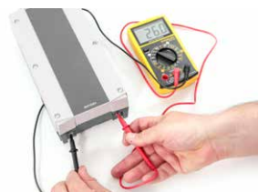
Kontrollera spänningen hos batteriet
