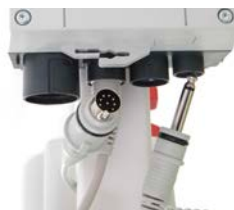
Überprüfung der Kabelverbindung
