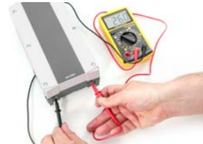
Spanning op de batterij controleren
