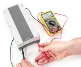
Kontrollera spänningen hos batteriet
