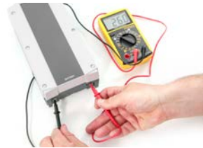
Überprüfung der Spannung der Batterie
