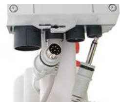
De aansluiting van de bekabeling controleren
