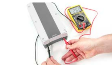
Spanning op de batterij controleren
