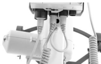
De aansluiting van de bekabeling controleren
