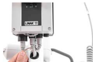
Überprüfung der Kabelverbindung
