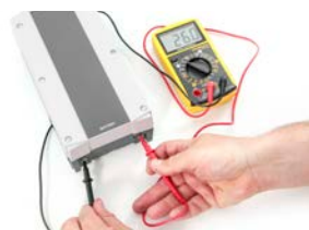
Spanning op de batterij controleren
