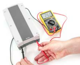
Kontrollera spänningen hos batteriet
